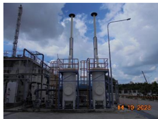
รูปที่ 3.5 ปล่องระบบดูดซับไฮโดรคาร์บอนอินทรีย์ด้วยถ่านกัมมันต์จากระบบบำบัดน้ำเสีย (D-9201 และ D-9202)
