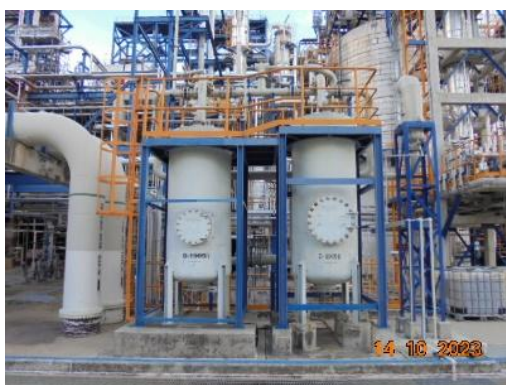
รูปที่ 3.4 ปล่องระบบดูดซับไฮโดรคาร์บอนอินทรีย์ ด้วยถ่านกัมมันต์จากระบวนการผลิต (D-1905A และ D-1905B)
