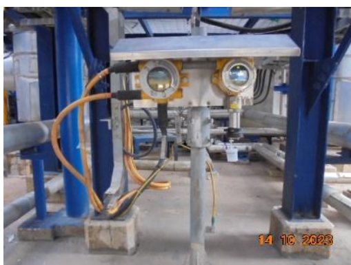
รูปที่ 3.7 อุปกรณ์ตรวจวัด/อุปกรณ์ความปลอดภัย ในระบบท่อลำเลียง
