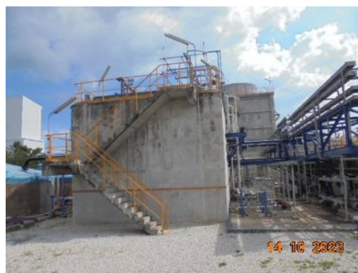
รูปที่ 3.23 ถังเติมอากาศ (AS System (แบบ SBR))
