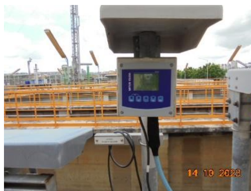
รูปที่ 3.19 ระบบตรวจวัดค่า pH แบบอัตโนมัติ
