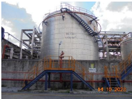
รูปที่ 3.57 คันคอนกรีตล้อมรอบถังเก็บกัก
