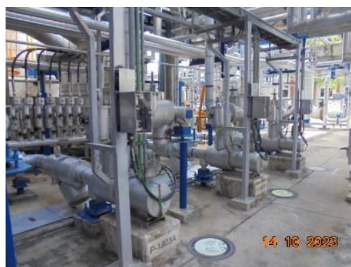
รูปที่ 3.8 เครื่องสูบน้ำสำรอง
