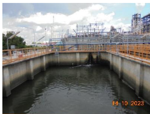
รูปที่ 3.17 บ่อพักน้ำทิ้ง (Final Polishing Tank)
