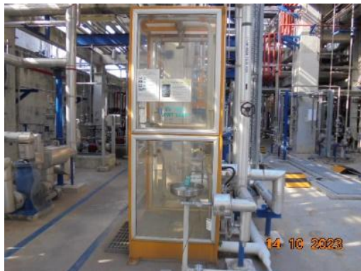
รูปที่ 3.51 อ่างล้างตาและร่างกายฉุกเฉิน
