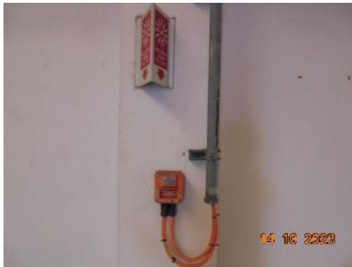
รูปที่ 3.40 ระบบเตือนภัย และระบบป้องกันและระงับอัคคีภัย ภายในอาคารพักของเสียของโครงการ โรงงานผลิตสารบิสฟีนอล เอ
