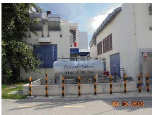
รูปที่ 3.9 ระบบจ่ายไฟฟ้าสำรอง
